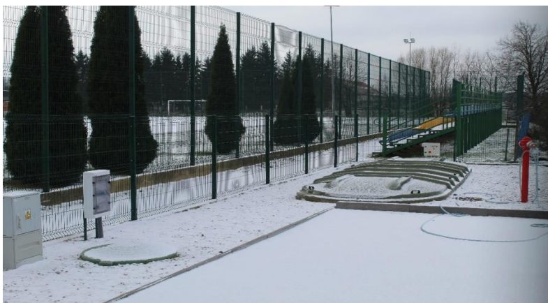
Oczyszczalnia ścieków przy Zespole Szkolno-Przedszkolnym w Nowych Piekutach
