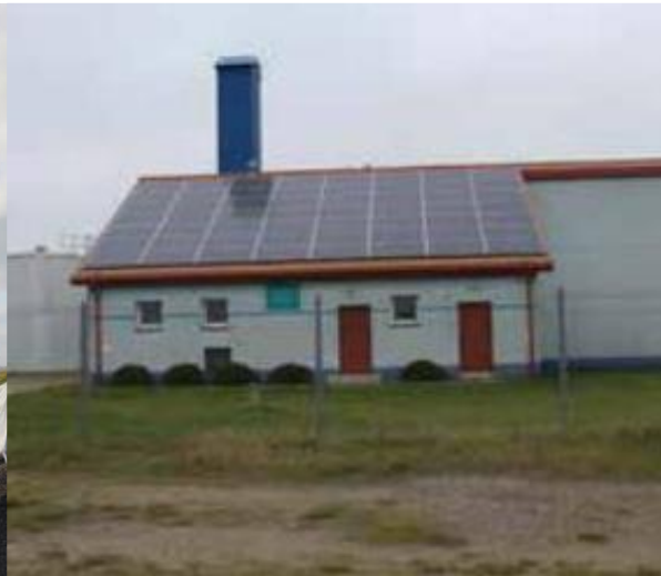
Stacja uzdatniania wody w Wierzbowiznie
