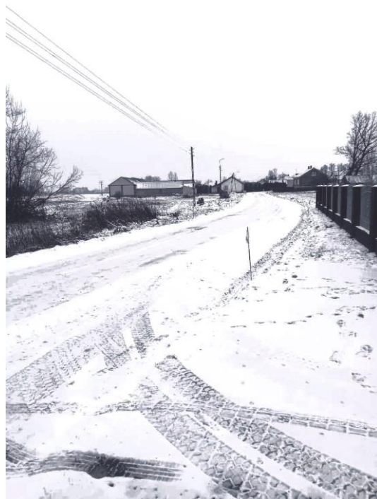
Droga w Jabłoni Dobkach w trakcie przebudowy
