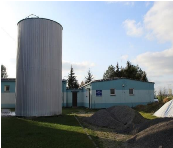
Stacja uzdatniania wody w Nowych Piekutach
