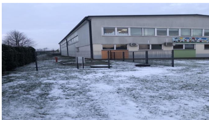
Oczyszczalnia ścieków przy Zespole Szkolno-Przedszkolnym w Jabłoni Kościelnej
