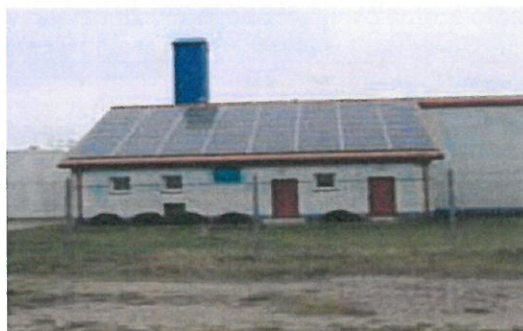
Stacja uzdatniania wody w Wierzbowiznie
