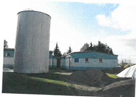
Stacja uzdatniania wody w Nowych Piekutach
