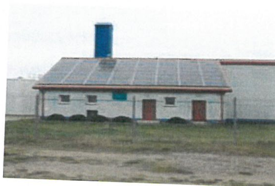
Stacja uzdatniania wody w Wierzbowiznie
