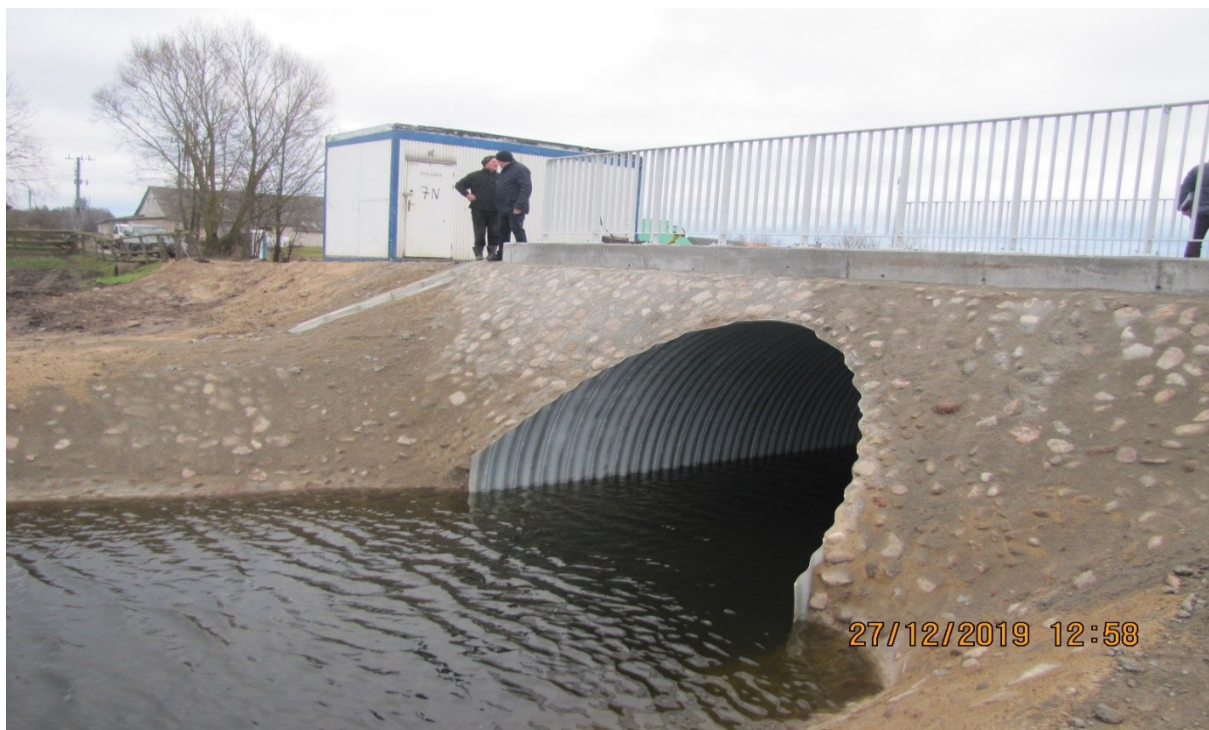
Most na rzece Tłoczewka w miejscowości Nowe Rzepki
